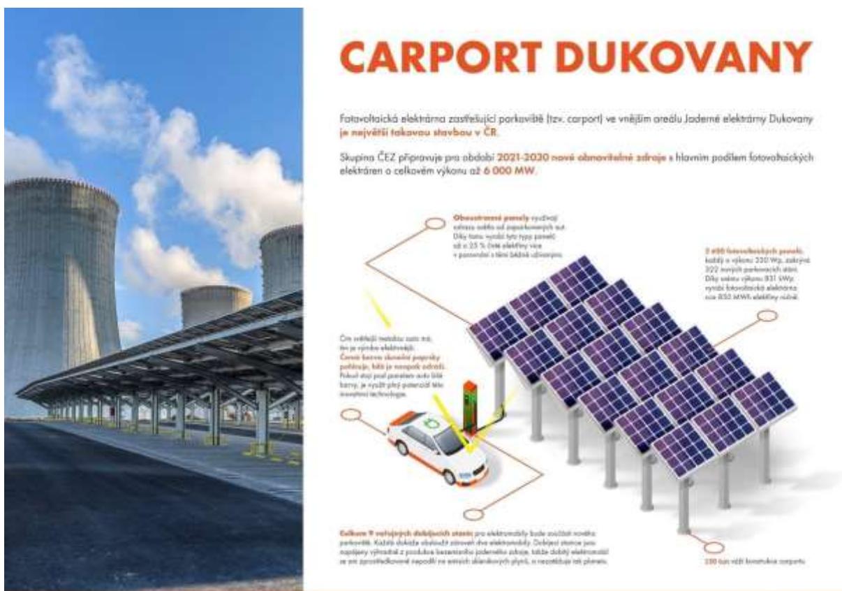
Obrázek 41: Carport Dukovany 322 parkovacích stání krytých oboustrannými FV panely (zdroj cez.cz)
