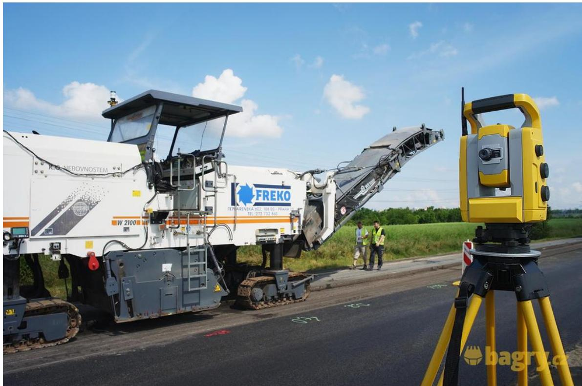
Obr. 4 – Frézování vozovky na základě digitálních podkladů. Zdroj Freko
